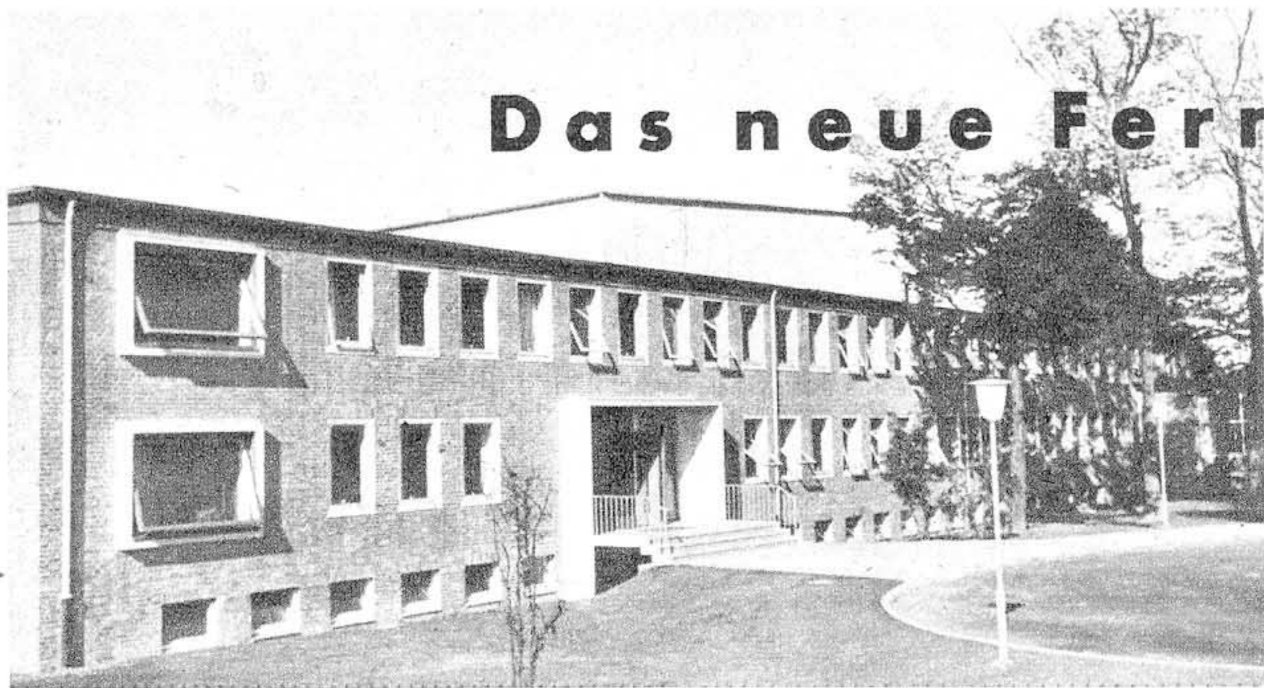
Haupteingang des Fernsehgebäudes; der überhöhte Dachaufbau befindet sich über dem Studio C
